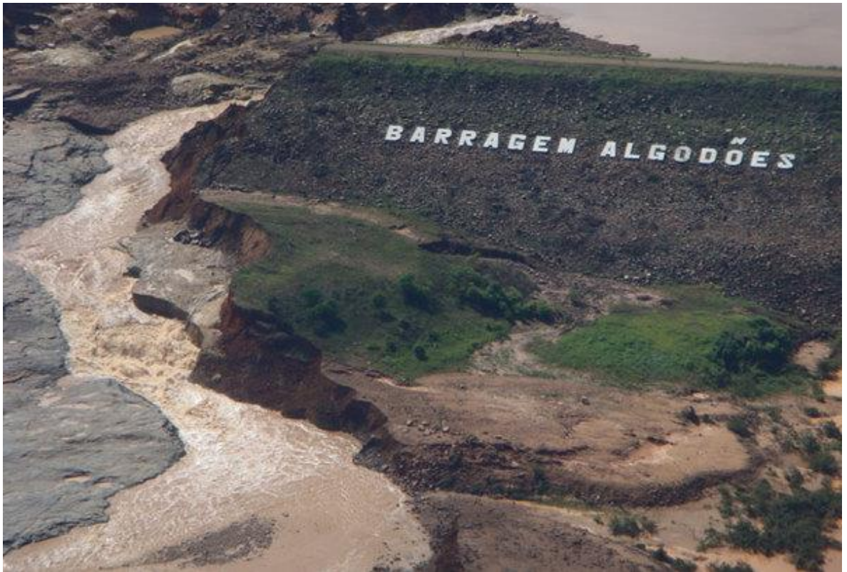
Figura 08 – Barragem de Algodões, pouco após o rompimento ocorrido no ano de 2009. Fonte: http://www.portalcotanorte.meionorte.com
