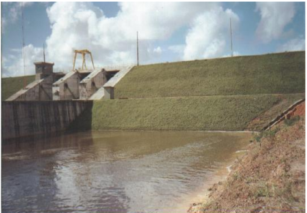
Figura 32 – Barragem de Santa Helena após processo reconstutivo, Fonte: Erton, 1999.
