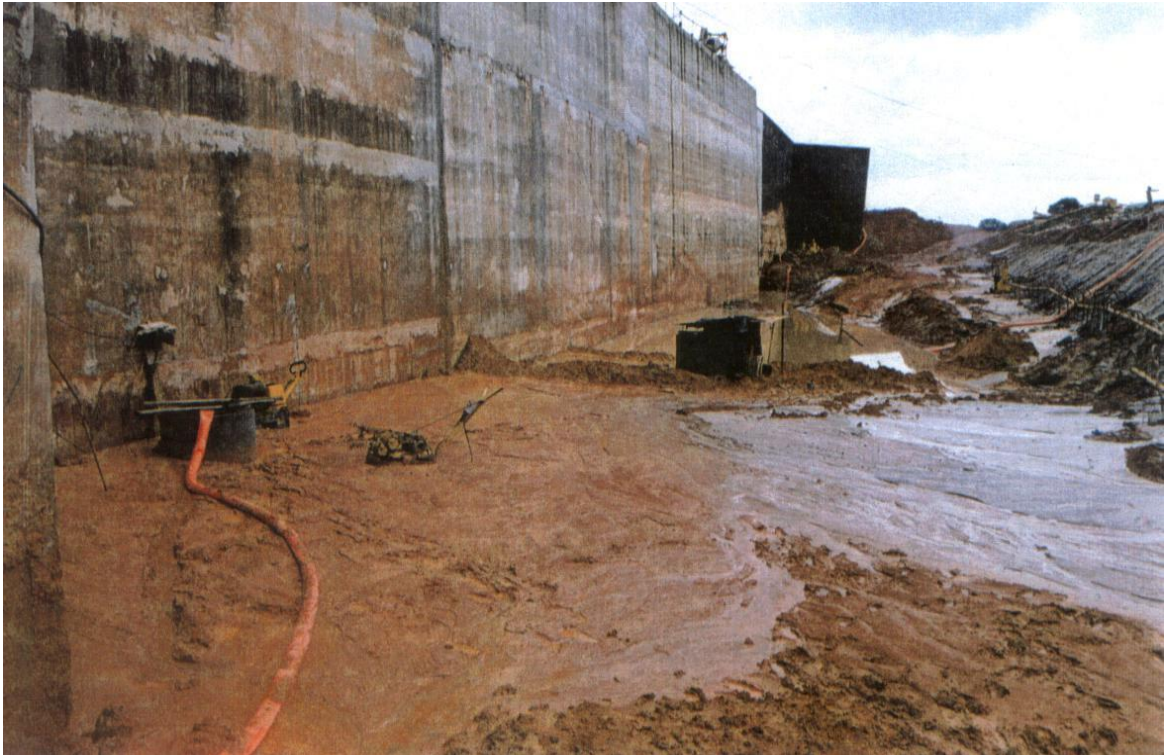
Figura 31 – Processo de remoção do material saturado, Fonte: Erton, 1999.
