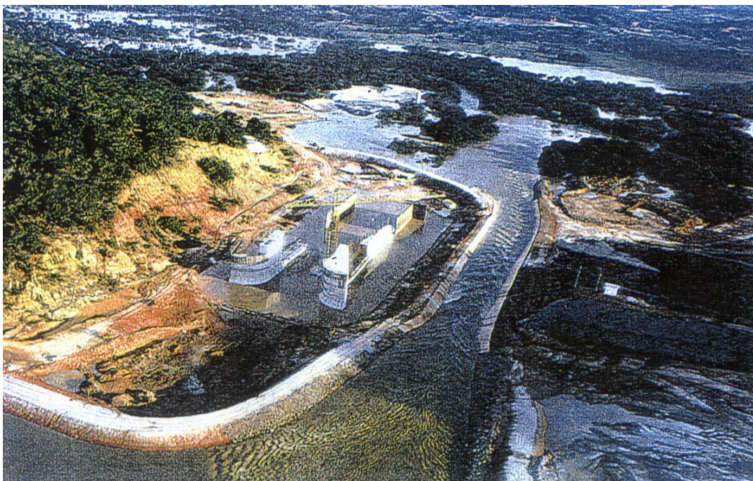
Figura 29 – Ensecadeira e canal de desvio revestido em concreto, Fonte: Carvalho, 1999.
