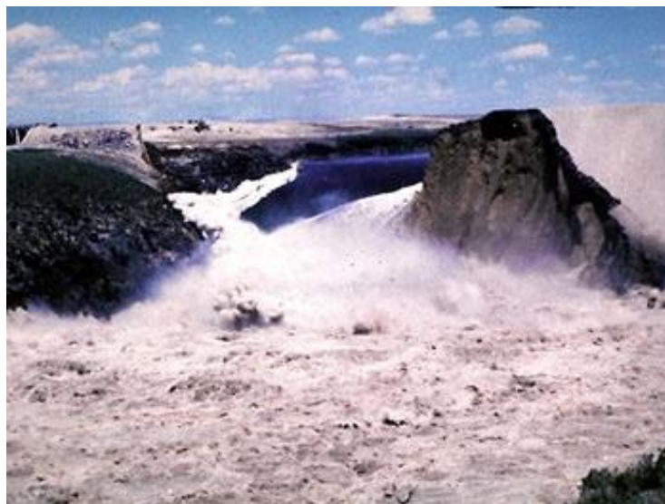
Figura 02 - Barragem de Teton, USA - 1979, momentos após a ruptura. Fonte: Fernandes, 1977.
